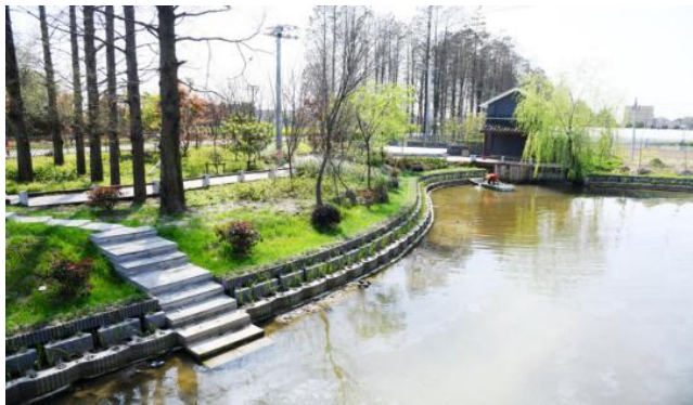
■ 海盐百步镇超同村河道整治工程
