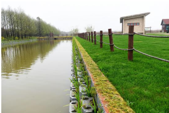
■ 上海崇明岛湿地生态挡墙工程
