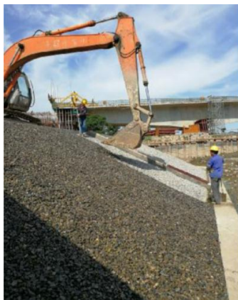
■ 机械及人工摊铺聚氨酯碎石面层
