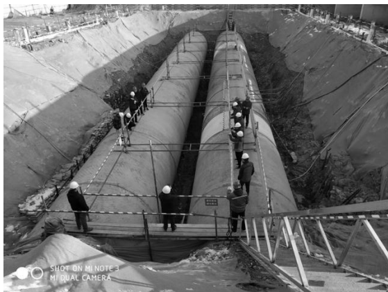
■ 典型管节开挖验证现场
