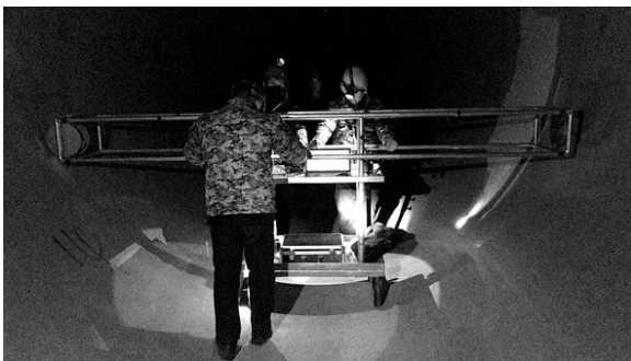
■ 检测装置在人力推动下沿管道轴线方向匀速移动
