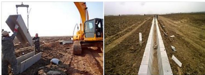
■ 矩型渠道施工现场
