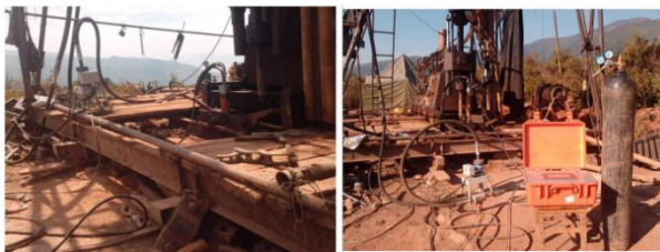
■ 云南某引水工程随钻压水试验现场场景
