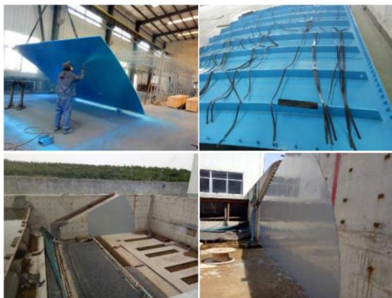
■ 闸门的混凝土导轨纳硅防腐涂装
