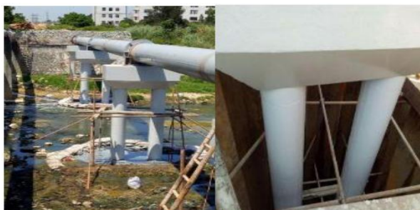
■ 福建金门供水项目混凝土桥墩重防腐
