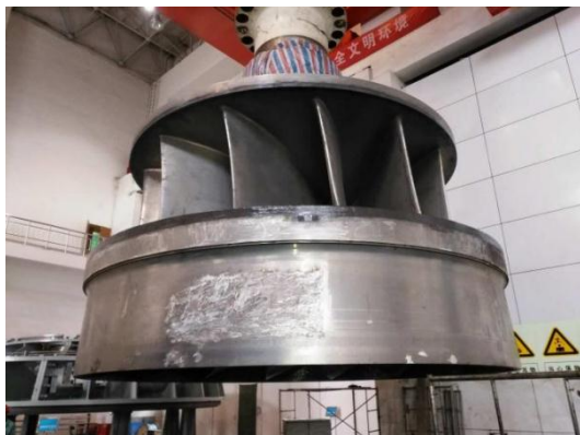
■ 万家寨水电站 2 号机组水轮机转轮抗磨防腐涂层修复
