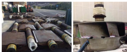
■国网新源白山电站 6 号机导叶汽蚀部位修复
