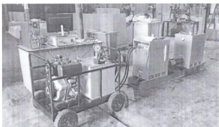
■ 应急操作器检测
