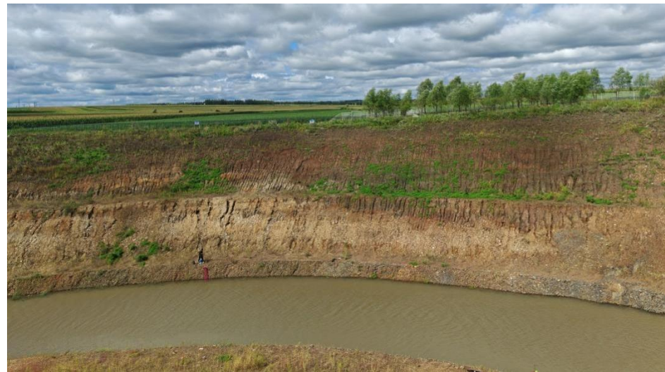
渠首部分边坡需要补植补种
