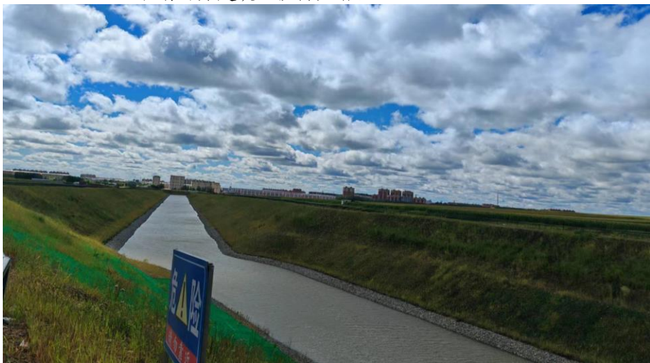
干渠边坡植草防护
